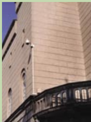
Radom: trasa kablowa na ratuszu w Radomiu – biała listwa kolorystycznie odcina się od elewacji
