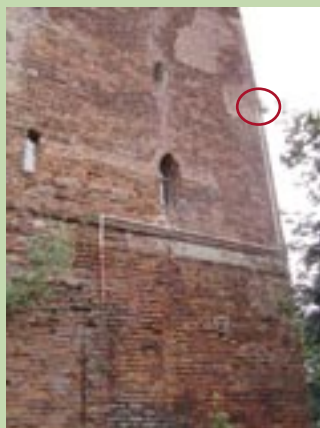
Malbork: widoczna trasa kablowa kamery na gotyckiej bramie
